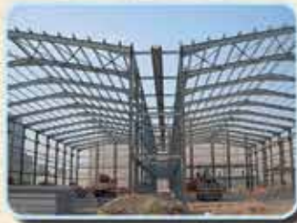
تركيب الهياكل الحديدية بأحدث التقنيات
