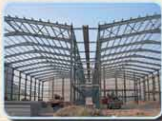
تركيب الهياكل الحديدية بأحدث التقنيات
